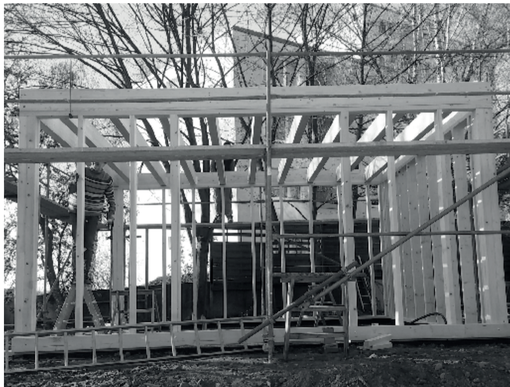
▲ SSM: Trotz Pandemie kommt der Bau des Rhein-Cafés gut voran.
